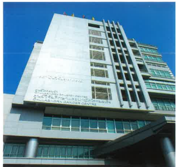
รูปที่ 5.5 อาคารศูนย์วิจัยศึกษาและบำบัดโรคมะเร็ง สถานที่ตั้งระบบทำน้ำร้อนพลังงานแสงอาทิตย์ ชั้นดาดฟ้าอาคาร
