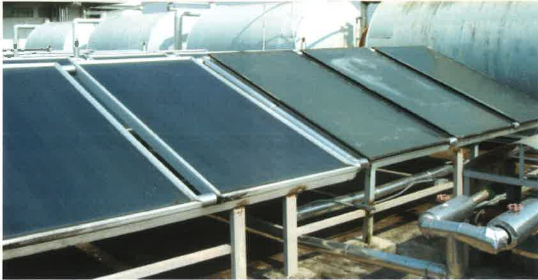
รูปที่ 5.3 ระบบผลิตน้ำร้อนพลังงานแสงอาทิตย์ โรงแรมดุสิต โฮเทลแลนด์ รีสอร์ท
