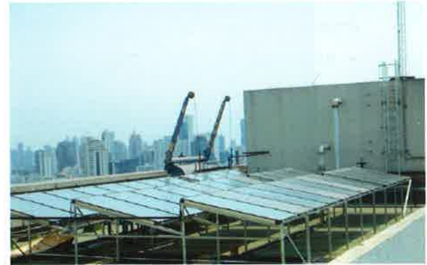
รูปที่ 5.14 ระบบผลิตน้ำร้อนพลังงานแสงอาทิตย์ โรงแรมรอยัล ออคิเดเชอราตันไฮเต็ล แอนด์ ทราเวอร์
