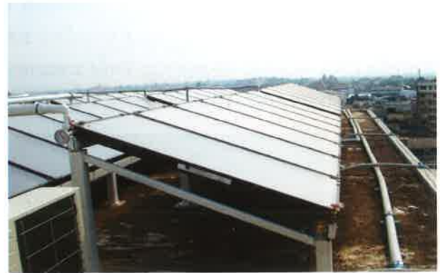
รูปที่ 5.12 ระบบผลิตน้ำร้อนพลังงานแสงอาทิตย์ บริษัท อุบลพัฒนา จำกัด (โรงแรมอุบลไฮเต็ล)
