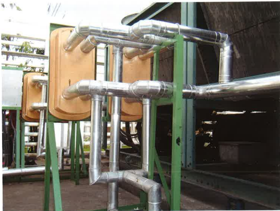
รูปที่ 5.8 ระบบผลิตน้ำร้อนโดยแลกเปลี่ยนความร้อนกับความร้อนเหลือทิ้งจากเครื่องปรับอากาศ โรงพยาบาลศูนย์วิจัยศึกษาโรคมะเร็ง สถาบันวิจัยจุฬาภรณ์
